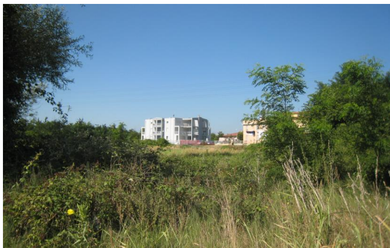
Foto 6 Nuovi edifici residenziali posti sull'orientamento nord-ovest
