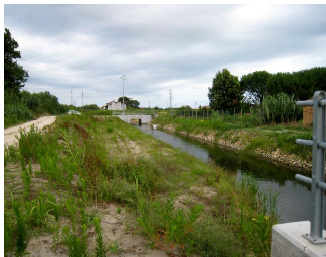
Foto 8 Il canale consortile che corre a lato della strada
